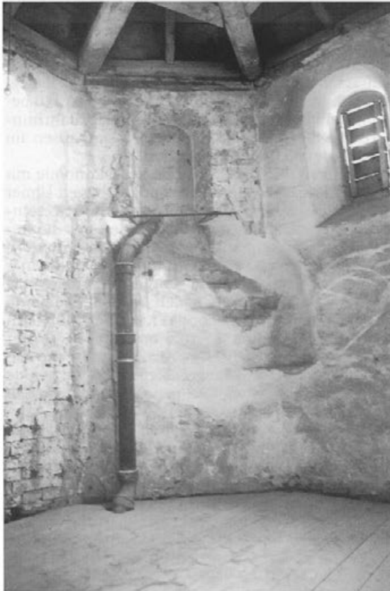
Fallrohr einer Traufrinne im Erkerturm des Konventbaus, das zur Latrinenkanalisation führt.
