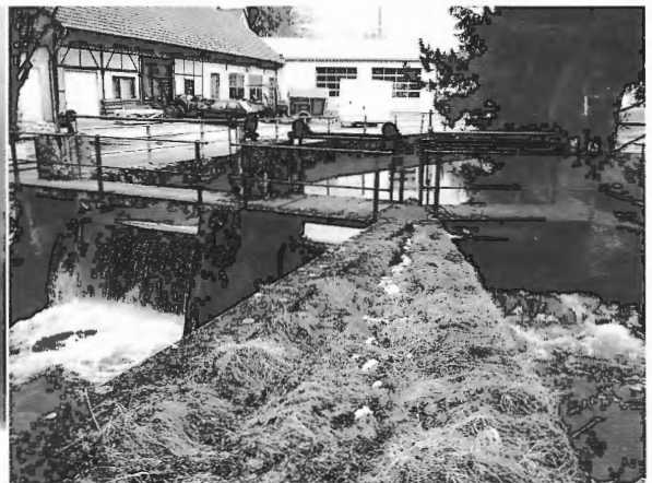
In Eberhardzell lassen sich noch die Trennung des Umlachwassers in einen Mühlkanal und ein Umleitungsgerinne erleben.
