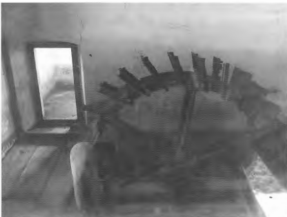
Eines der seltenen Wasserrad-Pumpwerke in Deutschland ist dasjenige der Heinrichsburg im Talgrund der Umlach von Eberhardzell.
