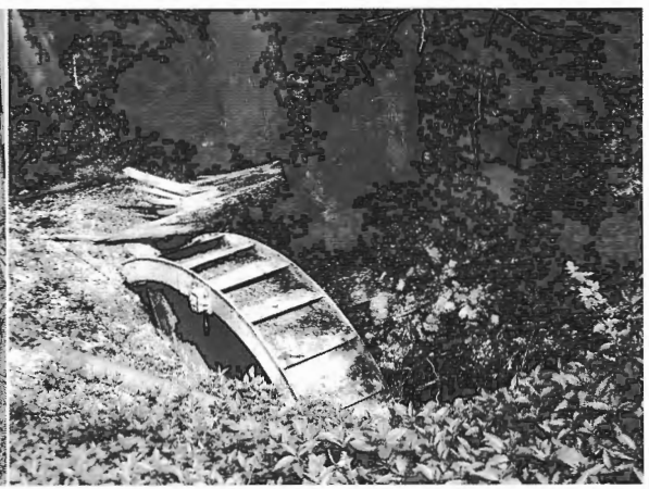
Ein verwunschener Ort im Dickicht des oberen Umlachtals: Bei Bauarbeiten im Frühjahr 2012 wurde das verschüttete Wasserrad der früheren Stampfmühle von Klingelrain kurzzeitig freigelegt.
