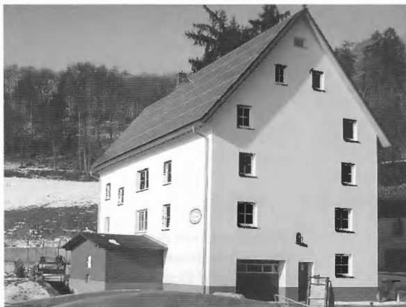
Ein gelungenes Beispiel für die Umnutzung alter Mühlengebäude: die Kunstmühle Krattenmacher in Eberhardzell ist heute ein individuelles Wohngebäude mit angebauter Radstube, in der das Wasserrad Strom erzeugt.
