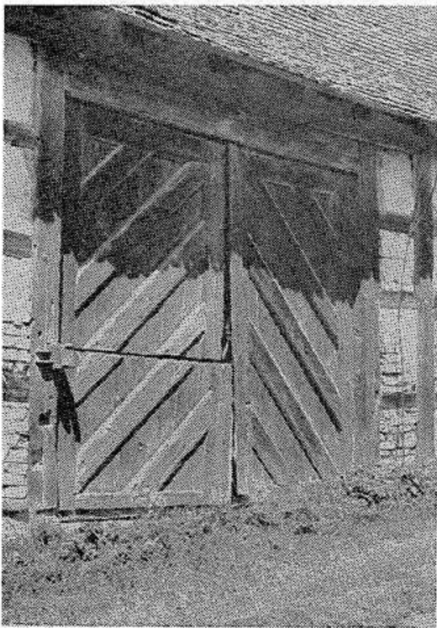
Tordetails des Zehntstadels mit hölzernen Torangeln und übersetztem Fachwerkgiebel.
