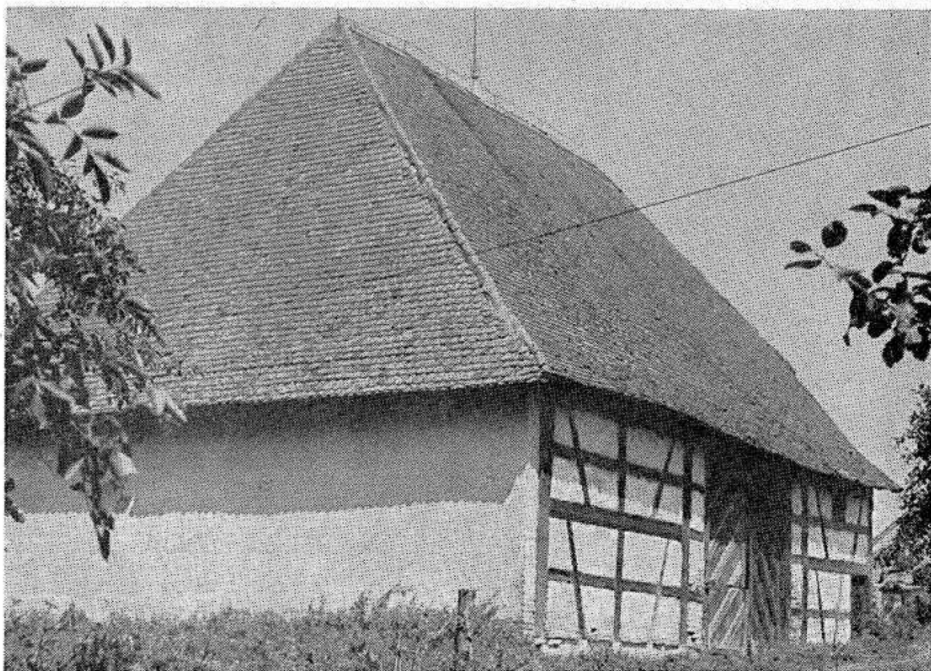
„Alter Zehntstadel“ in Eichen bei Stafflangen, errichtet durch das Kloster Schussenried.
